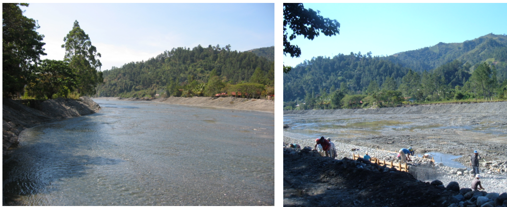
Imagen 19: Vistas del río Nizao, cuenca baja y trabajos de canalización
